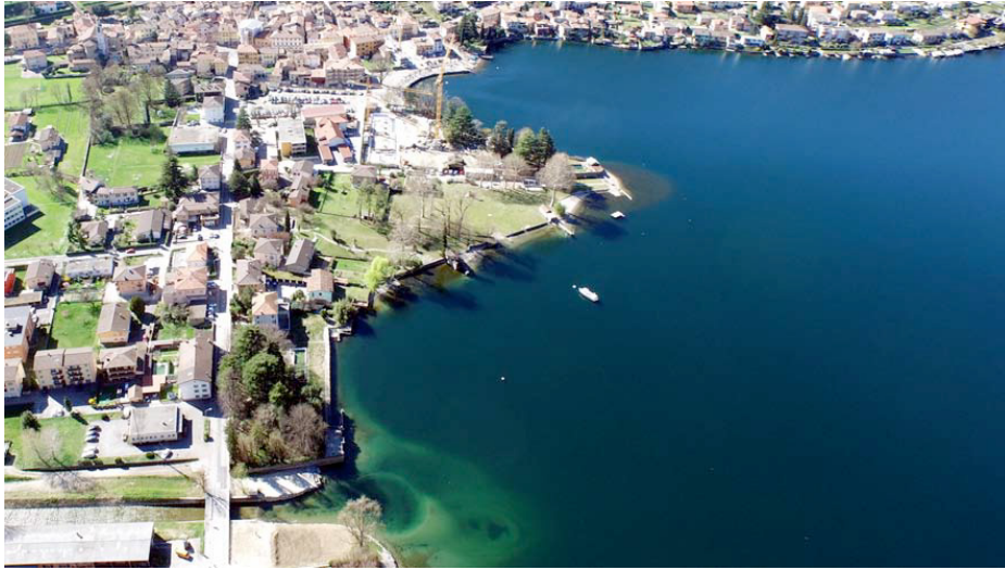
Figura 5: L'andamento favorevole della riva per la realizzazione di una passeggiata è facilmente visibile dalla fotografia a cavallo del vecchio delta del Laveggio. Allo stesso modo si vede la riva poco profonda in corrispondenza della testa della piazza, che andrà approfondita con rilievi specifici
