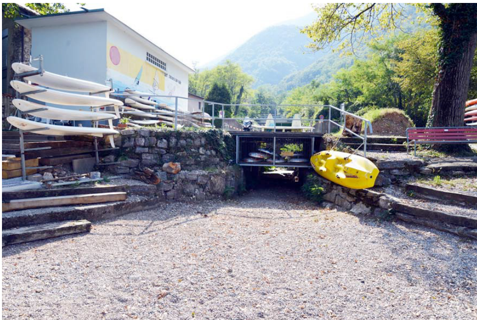
Figura 25: Il deposito di natanti all'interno del torrente
