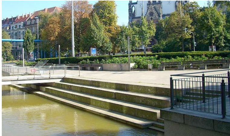
fig.20: Esempio massciata a gradoni, accesso diretto all'acqua
